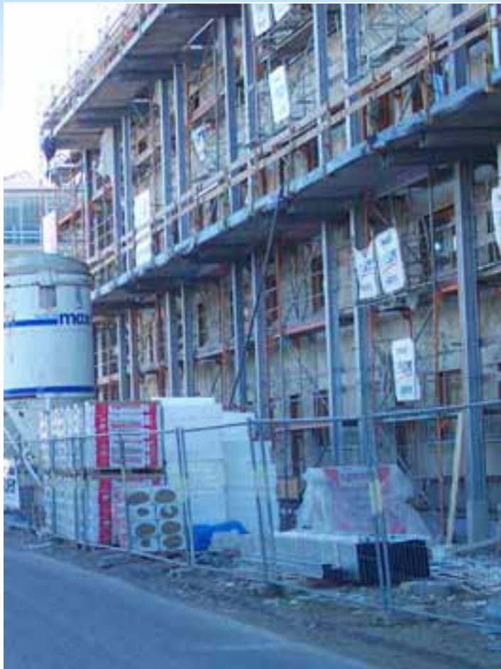
Vauban 3. BA: Styrolplatten warten auf ihren Einbau
