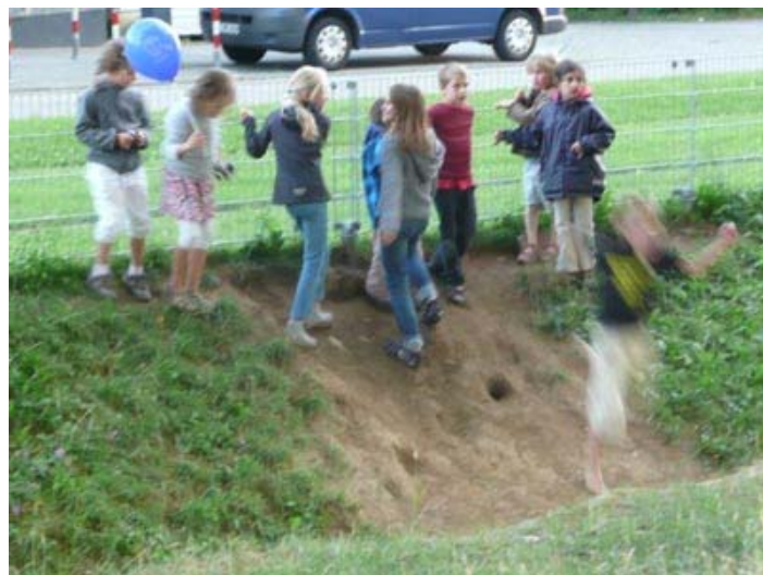
Der Regenwasser-Versickerungsgraben ist ein attraktiver Spielplatz – aber mit Folgen!
