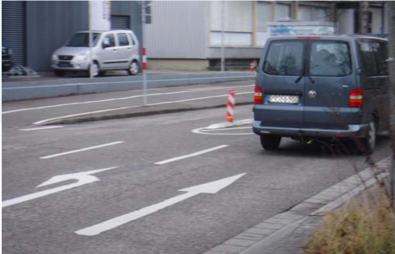
Der schraffierte Streifen sollte eine Interimslösung sein: zu schmal und eng im Gegenverkehr von PKW und LKW.
