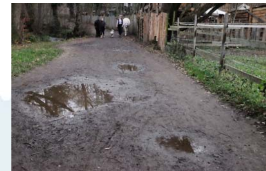
Auch dieser Wegabschnitt wird vorerst nur provisorisch durch Auffüllen der flachen Mulden ausgebessert. Foto: R. Schepers
