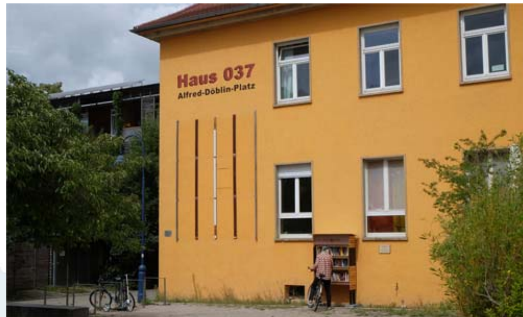
An der Südfassade des Stadtteilzentrums waren die Tafeln angebracht Foto: eRich Lutz www.stadtteilverein-vauban.de
