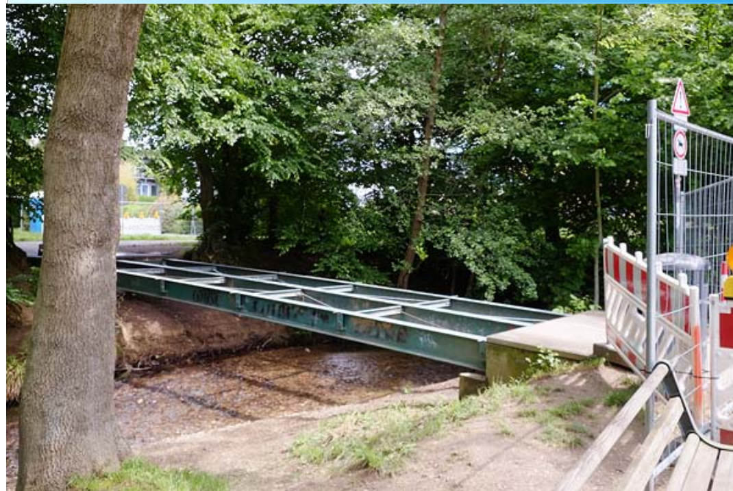
Im Jahr 2004 wurden die beiden Brücken über den Dorfbach hergestellt. Von der Bau-substanz sind jetzt nur noch die Stahlträger übrig. Foto: R. Schepers
