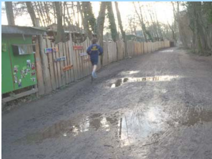
Durch ablaufendes Oberflächenwasser wird die Wegedecke stark aufgeweicht.
