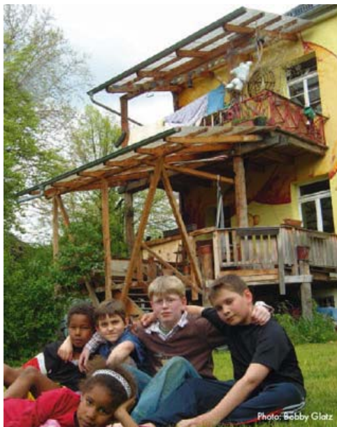
思い思いに造られたバルコニーと外階段 Photo: Bobby Glatz
