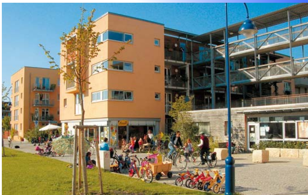
「ゲノヴァ II」の建物も渡り廊下でエレベーターを共有
