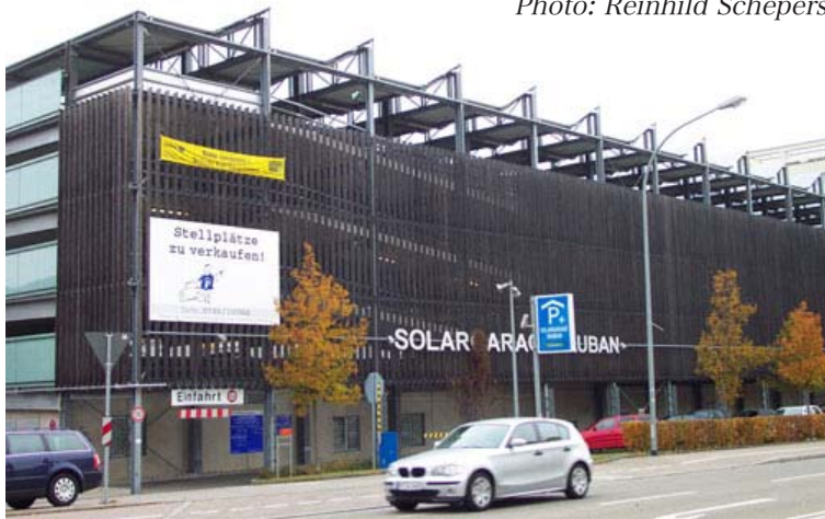
駐車場設置禁止区域の住民の車が収まる集合駐車場
